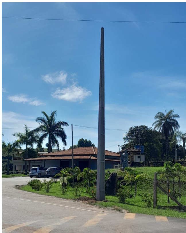
> Poste na comunidade do Maracujá
